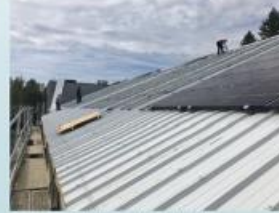
Finition de la toiture
