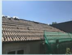
Mise en place isolant
