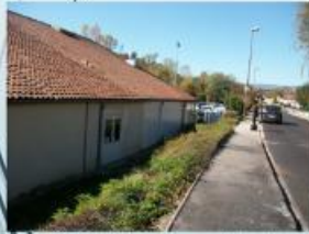
Dépose des tuiles existantes
